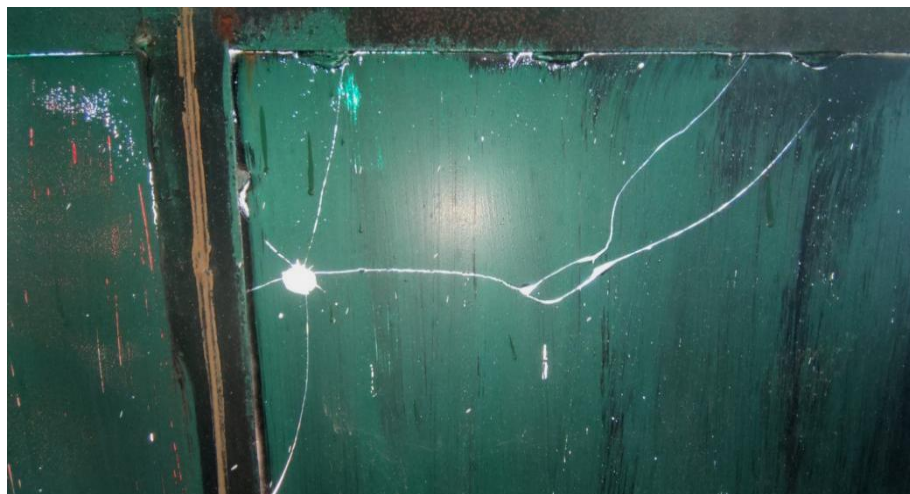
窗户玻璃开裂破碎
