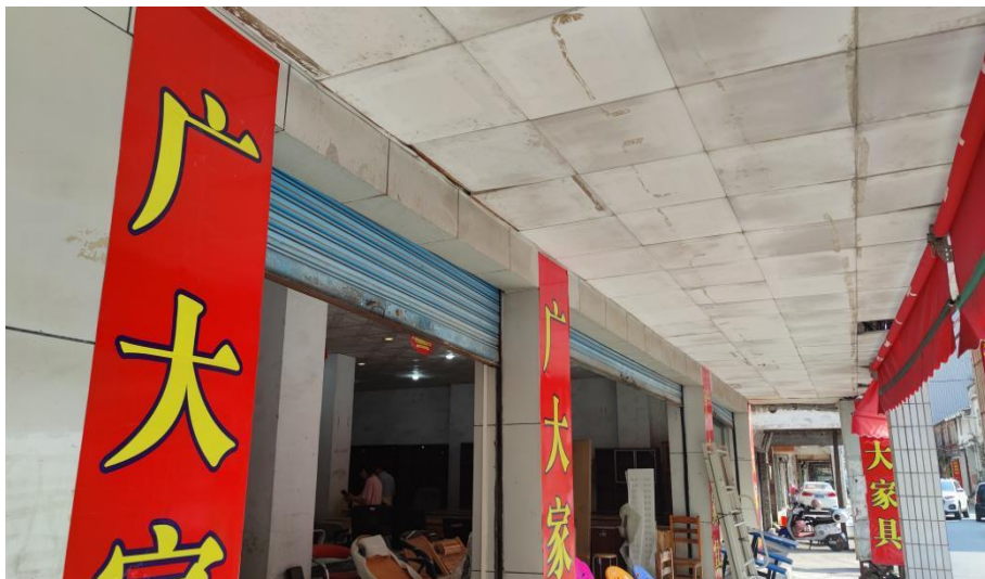
骑楼天棚吊顶
