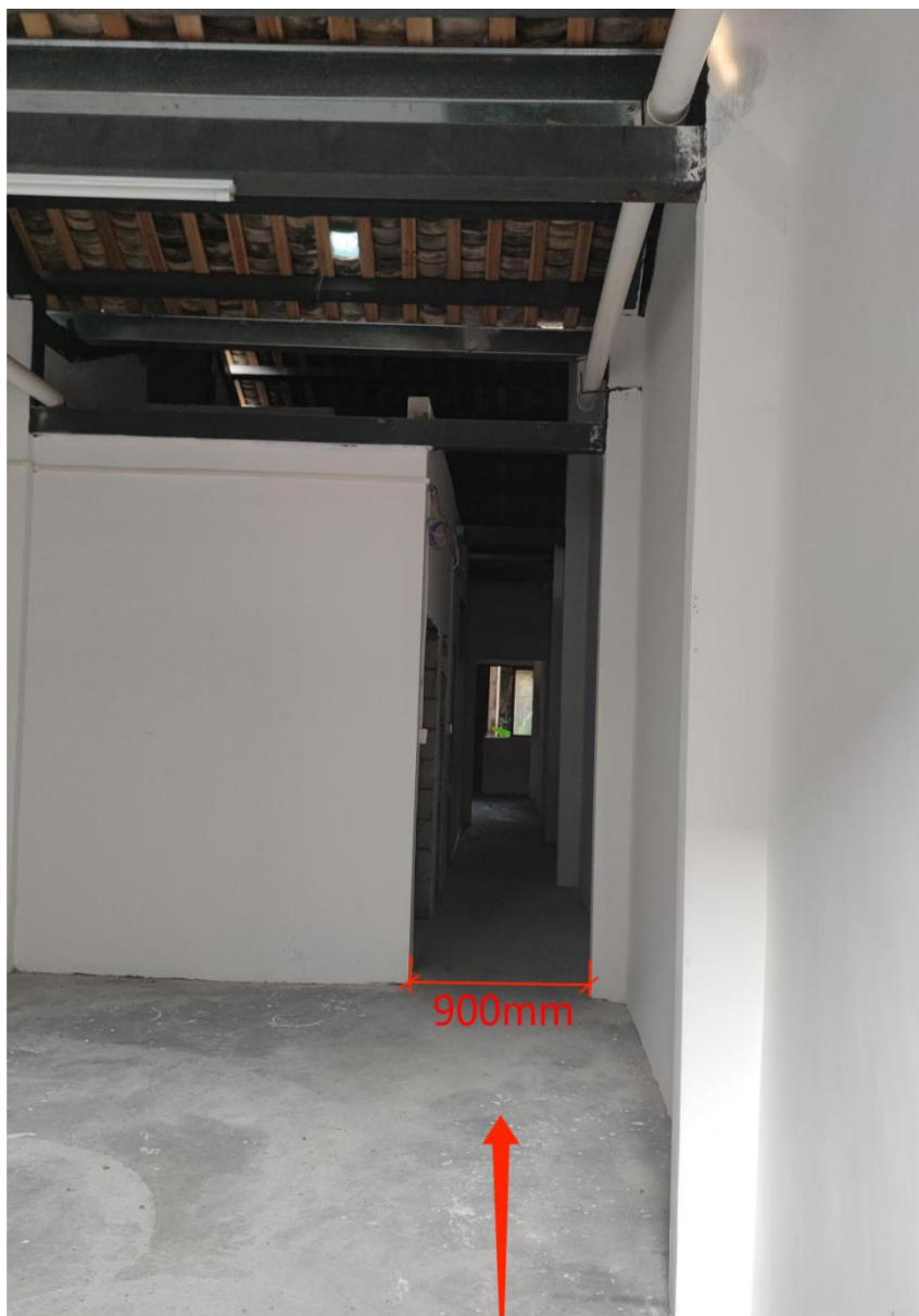
施工通道（往物业内）
