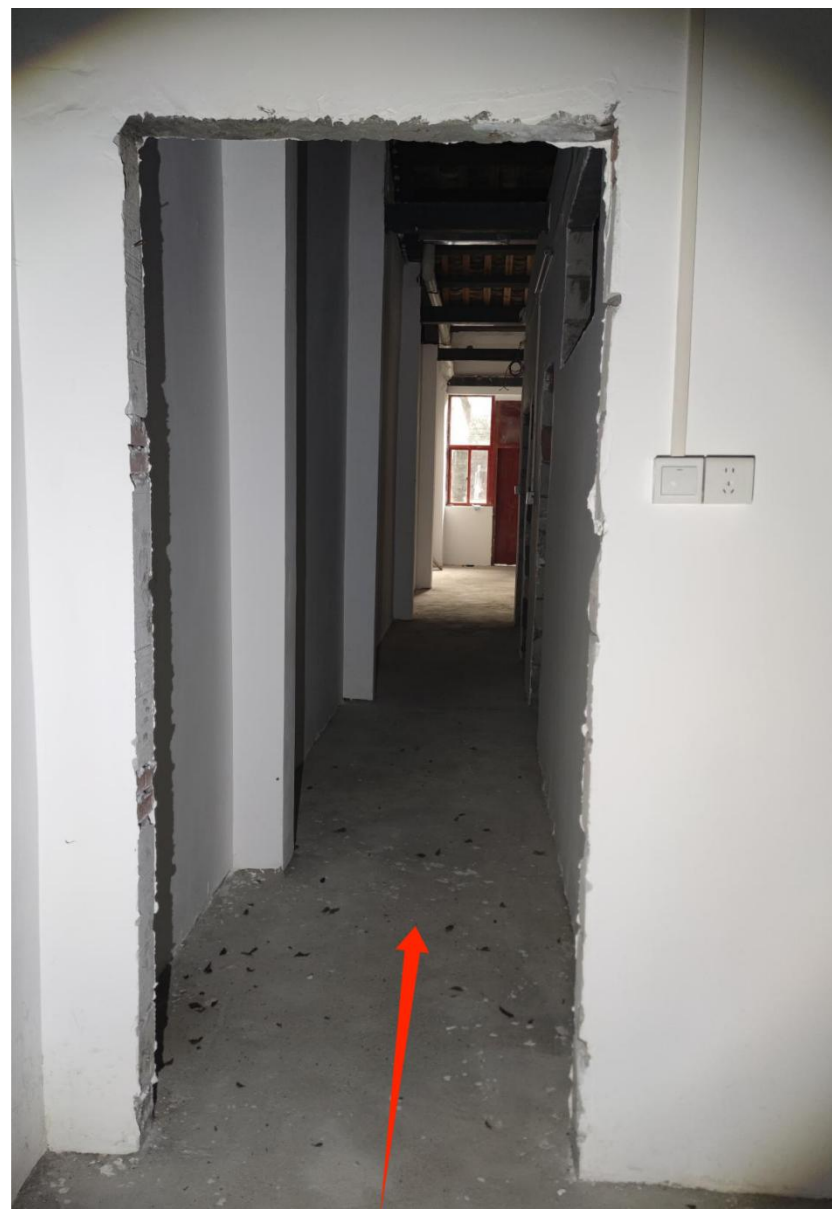
施工通道（往室外）
