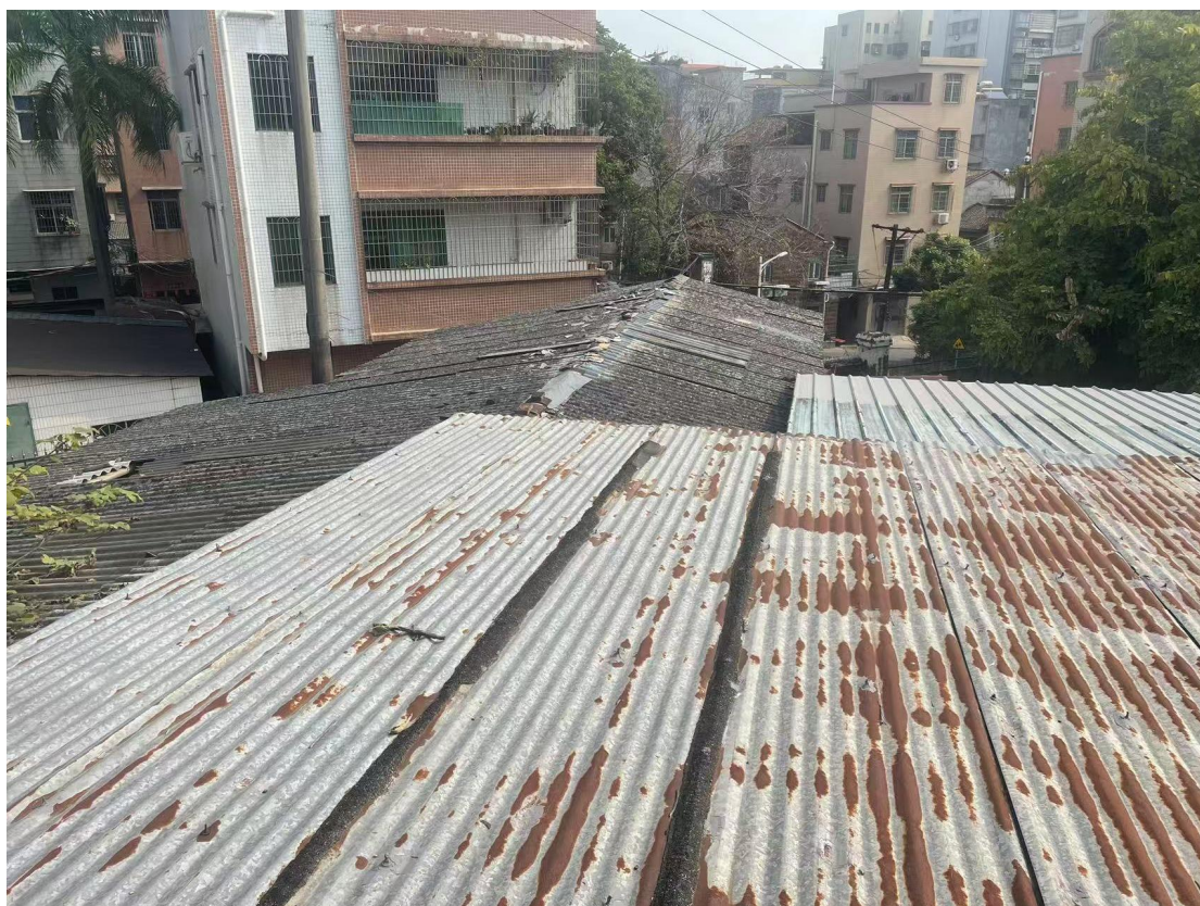
附件：1. 现场现状照片
